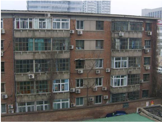
A. 5 floors, 1981 Split unit
